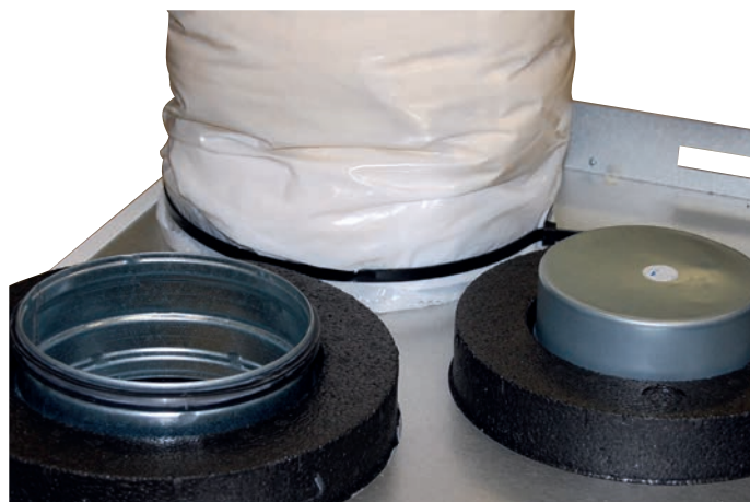
Joonis 21. Paigaldatud kanal
