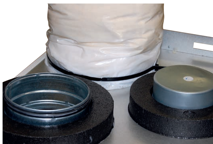
Figur 21 Færdigmonteret kanal
