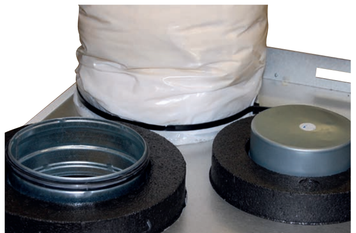
Kuva 21 Valmiiksi asennettu kanava
