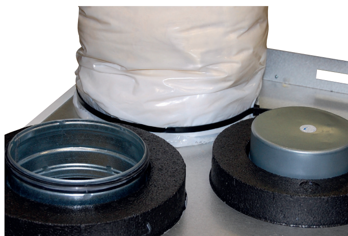
Ferdig montert kanal.
