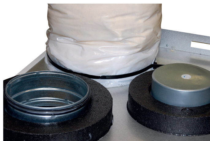
Ferdig montert kanal.
